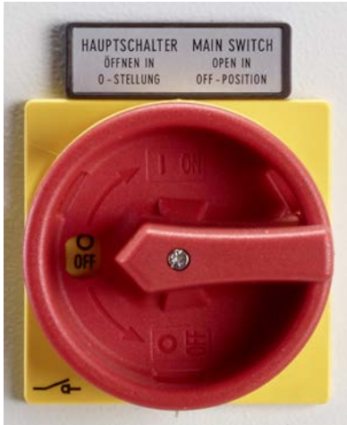
Fig. 1: Interrupteur électrique général
